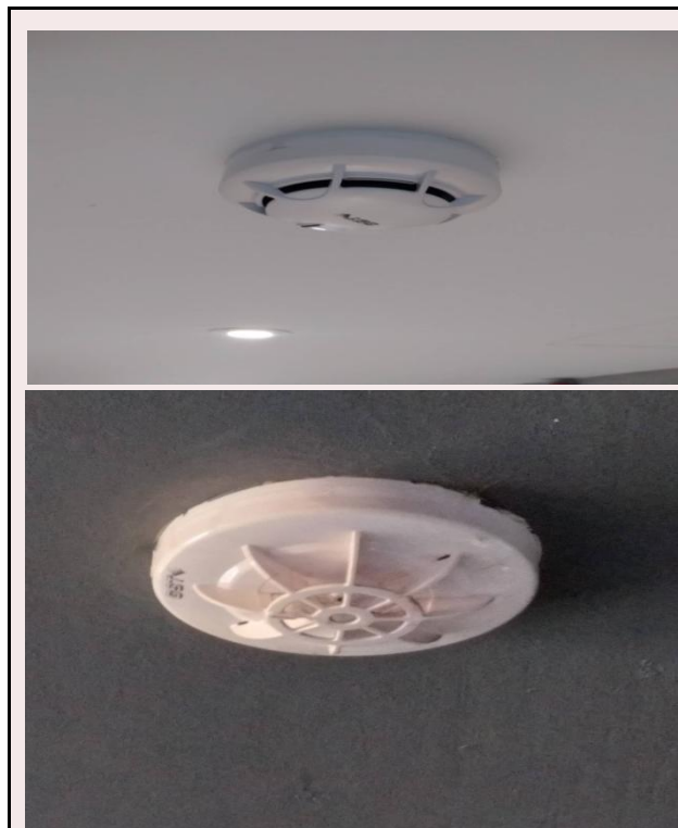
ภาคผนวกที่ 3.43 Smoke&Heat detector
